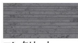
コンクリート グレー
